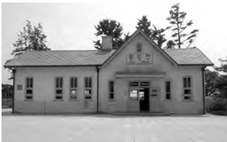
군산 구 임피역 보수 전
