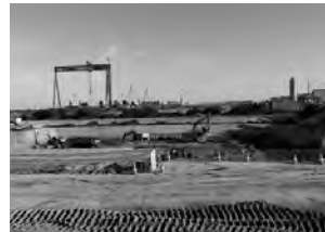
토목 공사 진행중
