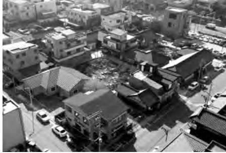
근대역사체험공간 2권역 전경 2015년 조성, 근린생활시설 6개동, 근대역사교육관 군산 향쟁관 등이 마련됨
