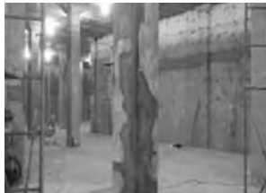
나운배수지 보수 (보수중)
