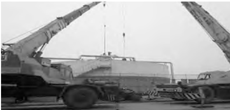
소화조 교반기 설치
