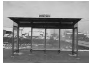
버스승강장에 기초번호판 설치
