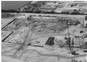
토목 공사 진행중
