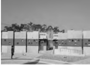
비응공원 화장실 (2012년 신축-비응도)
