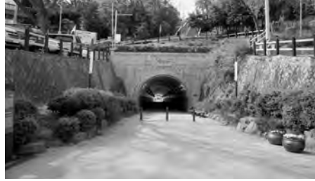
군산 해망굴 보수 후
