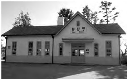
군산 구 임피역 보수 후
