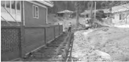
물복지 개인급수공사 (공사중)
