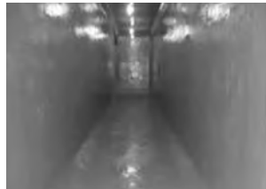
해망배수지 보수 (보수완료)
