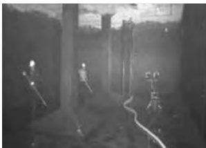
신평배수지 보수 (내부상태)
