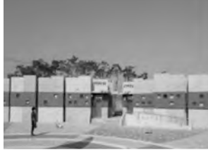
비응공원 화장실 (2012년 신축-비응도)
