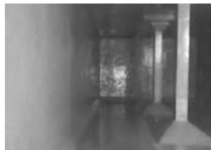
신평배수지 보수 (보수완료)
