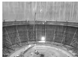
가스탱크 내부 보수
