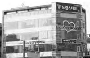
드림스타트 이전 개소 - 현부지 사진 전경 -
