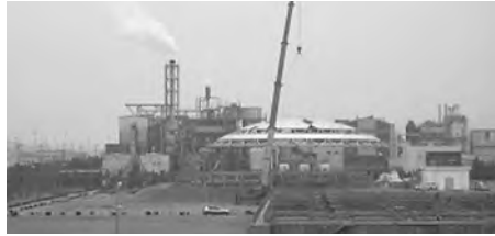
악취방지용 돔 설치
