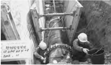
고군산군도 상수도 시설공사 - 오식도동 구간 (공사중)
