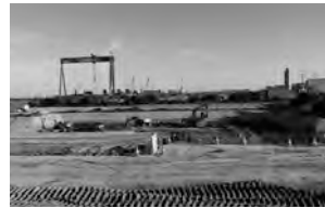
토목 공사 진행중
