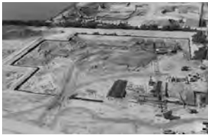
토목 공사 진행중
