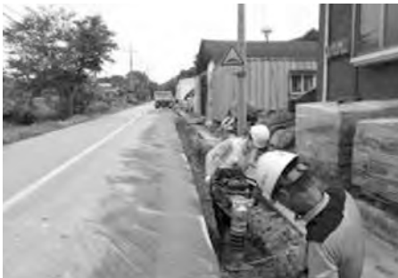
농어촌 지방상수도 확장공사 (공사중)
