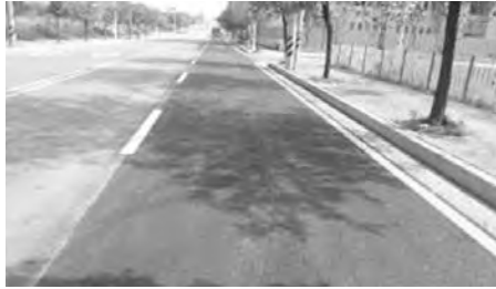
고군산군도 상수도 시설공사 - 오식도동 구간 (공사후)
