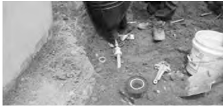
물복지 개인급수공사 (공사중)
