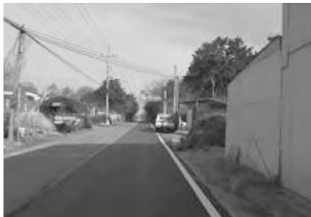
농어촌 지방상수도 확장공사 (공사후)
