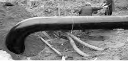
송풍기 배관 설치
