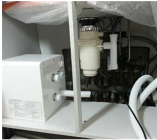
○ 분쇄기와 2차측(미생물액상발효소멸조)의 연결부를 단순자바라 호수로 쓰는 경우 - 일반 자바라 호수를 사용하여 설치
