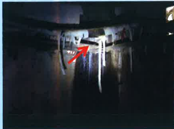
2. 월명아파트 - B동 PIT층
