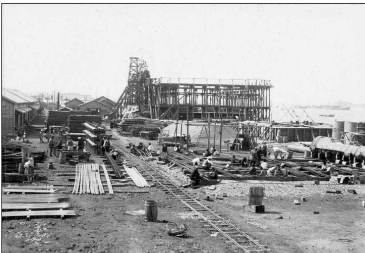
[잔교 공장 설비]
