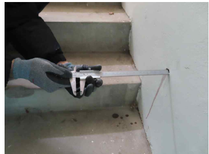
콘크리트 탄산화 깊이 조사
