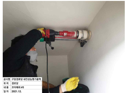
콘크리트 압축강도 조사
