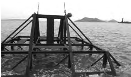
석재조합식 강제어초 설치
