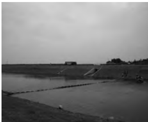
1차 오일웬스 설치
