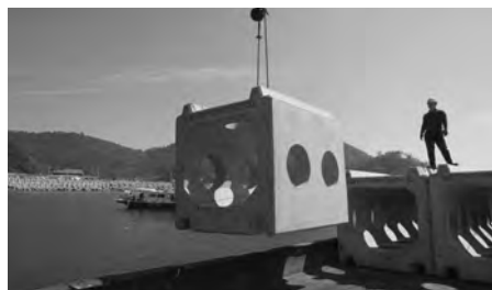
터널형 어초 설치
