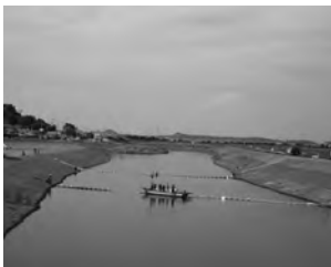
2차 오일웬스 설치
