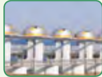
[동진강 취수보 시공]
