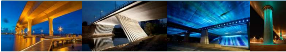
[표 4.33] 금강자전거길 / C 교량하부 조명 연출
